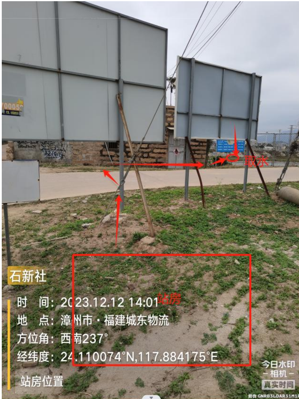
水站点拟建站房和取水现状图 1
