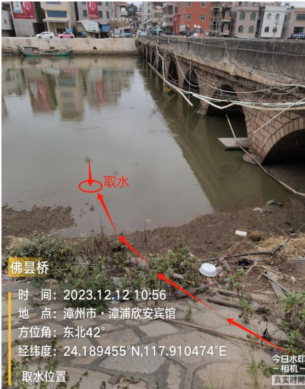
水站点拟建站房与采水点现状图 2
