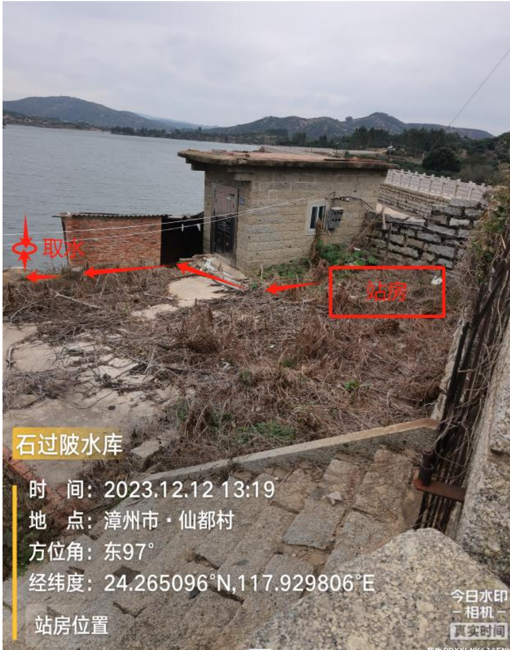
水站点拟建站房现状图 1
