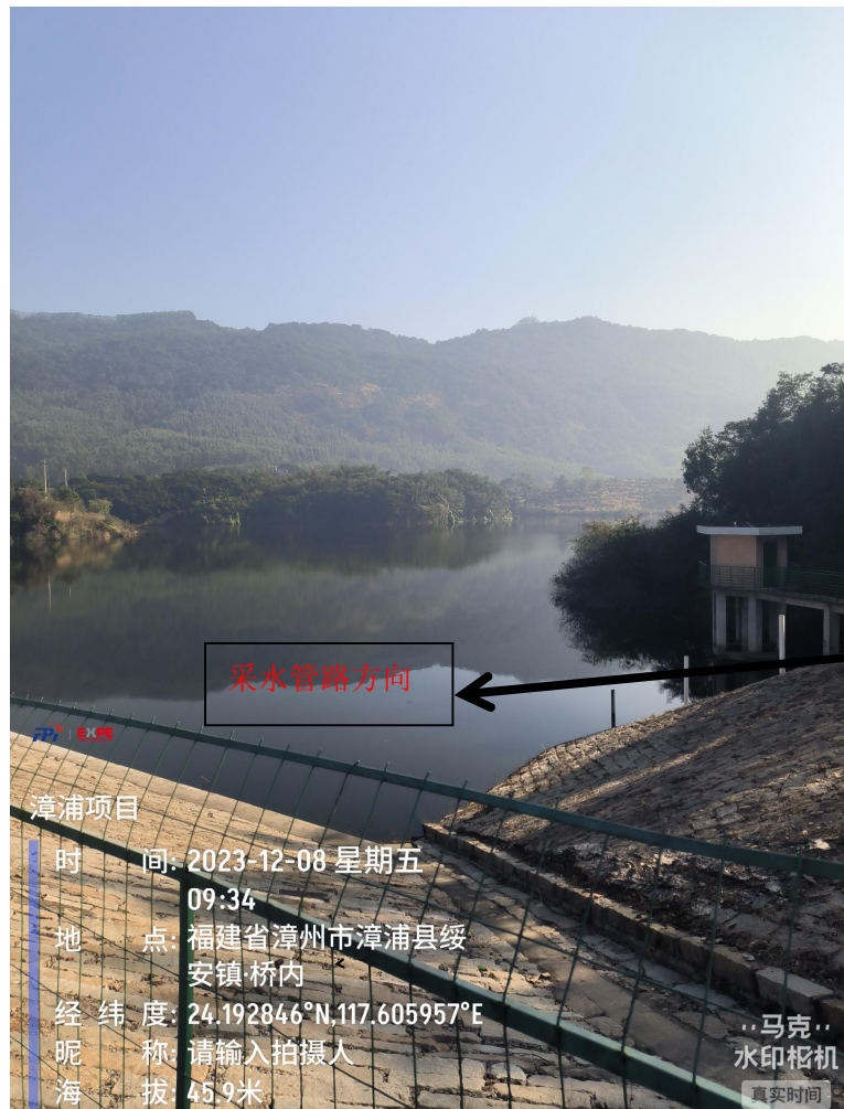
水站点拟建站房与采水点现状图 1
