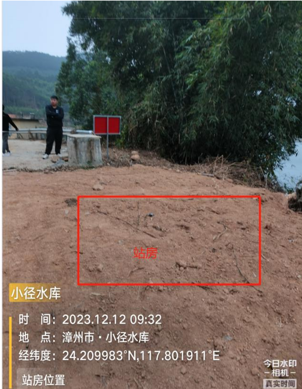
水站点拟建站房现状图 1
